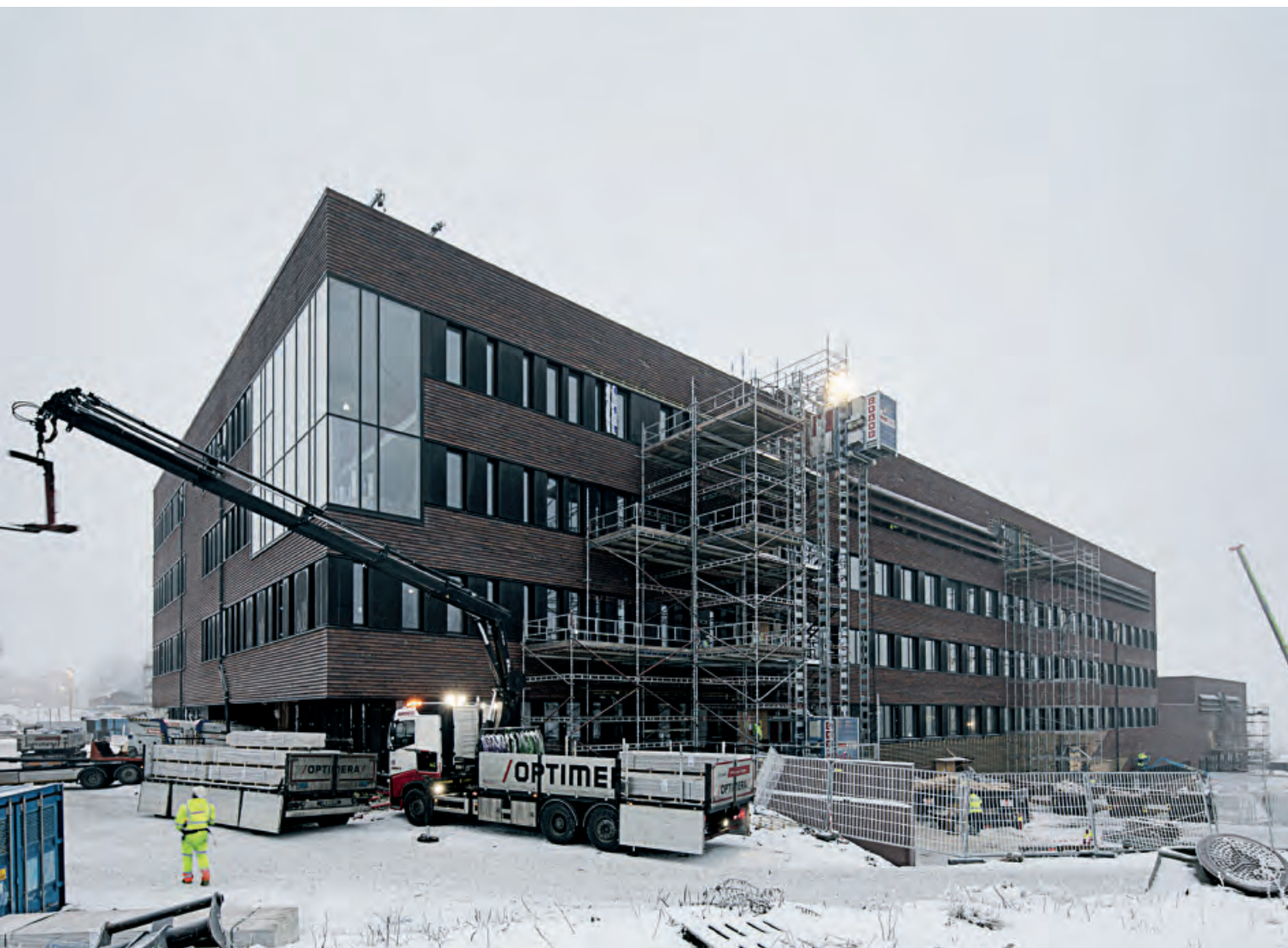
Det nye hovedbygget til Veterinærinstituttet på Ås begynner å ta form fram mot innflyttingen i 2020. Foto: Trond Isaksen, Statsbygg
